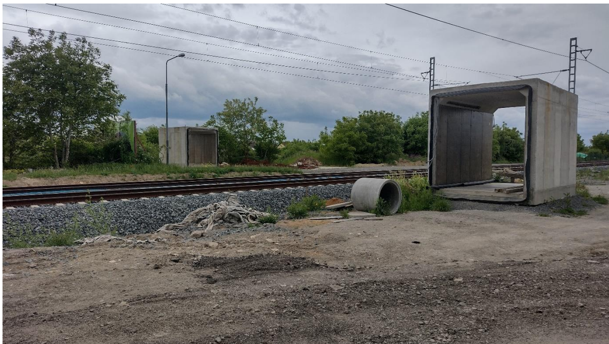
Obrázek 4 Prefabrikované moduly připravené na místě budoucího podchodu
